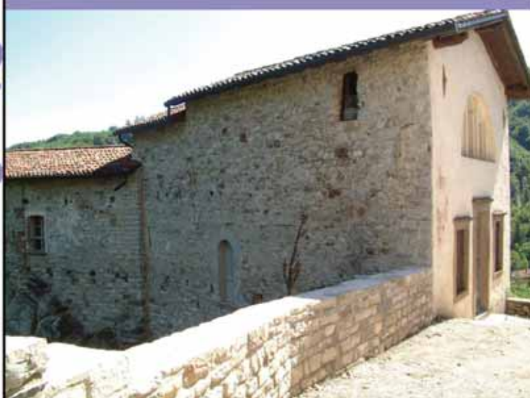
Prospetto laterale della chiesa di Santo Stefano
