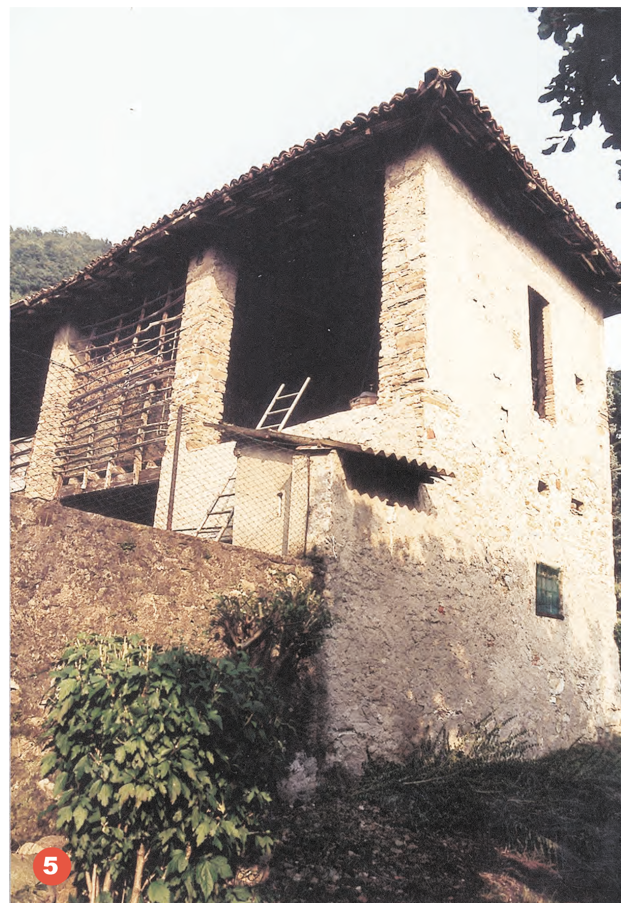
1 Tipica copertura in piode e coppi di un edificio rurale a mezza costa a Colle di Sogno
